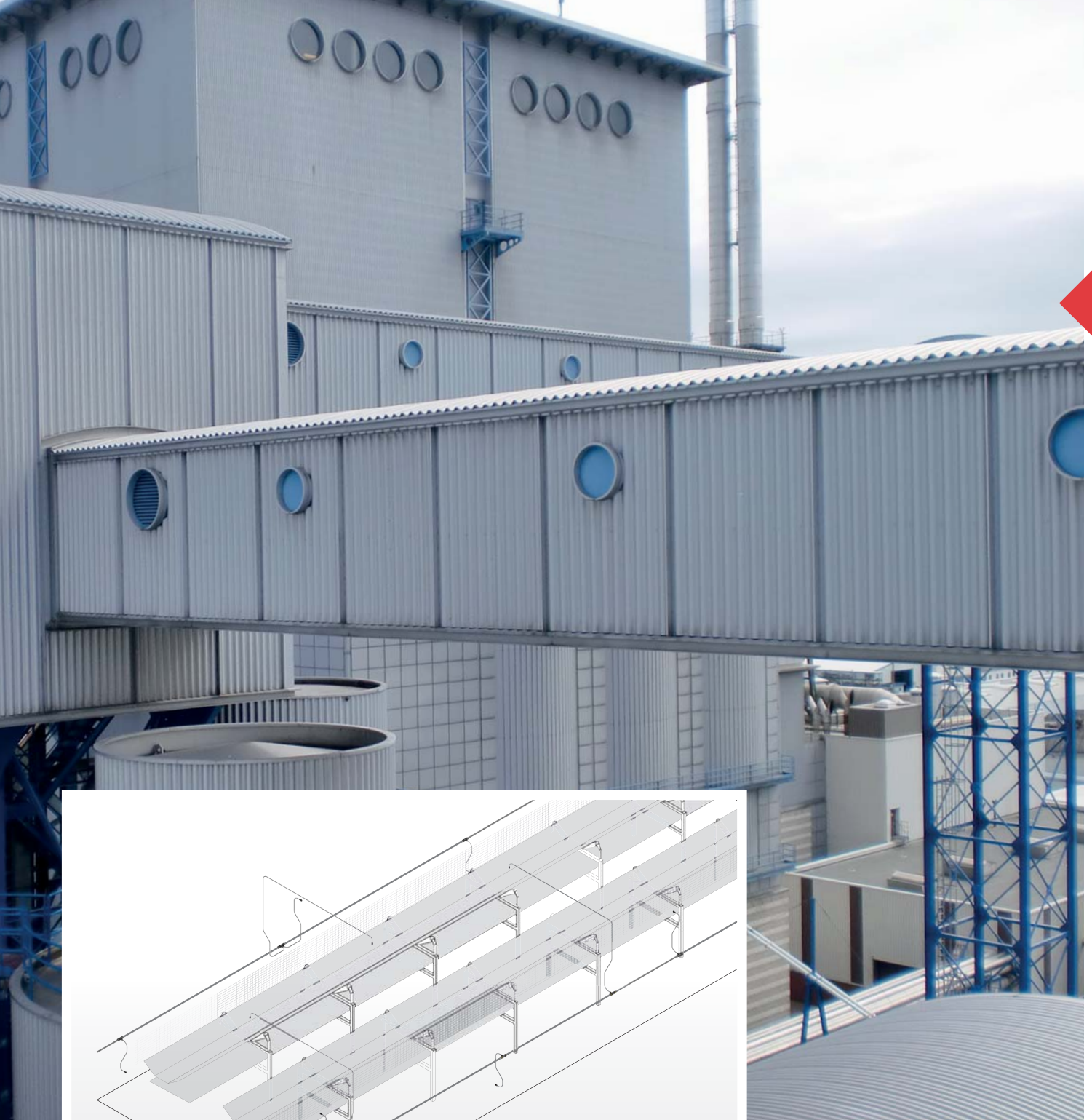
一个通道的 HI-FOG® 安装示意图。HI-FOG® 系统也被延伸到连接不同通道的塔中。管网和喷嘴绕塔壁布置。
