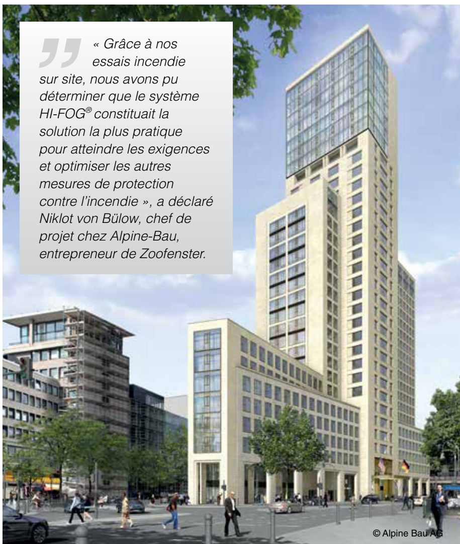
Immeuble Grande Hauteur Zoofenster, Berlin.
